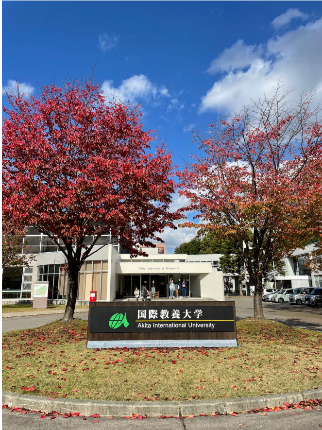
AIU: Fall facade (10.19.2022)
